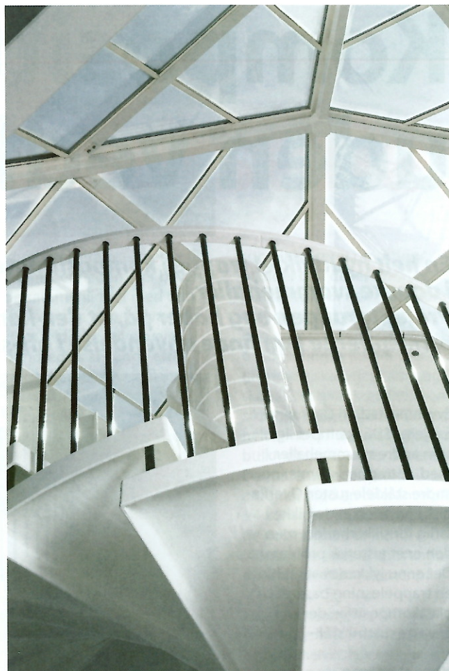
Trappens trin er i glasfiber- og balustrene kulfiberplast.
