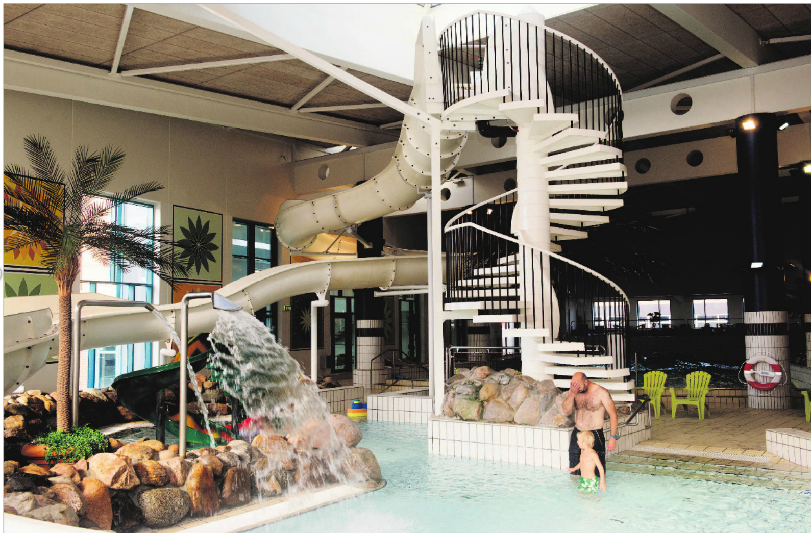
Komposittrappen i Svømmestadion Danmark i Esbjerg er noget pænere at se på end de traditionelle ståltrapper og har flere andre fordele, når det handler om holdbarhed og vedligeholdelse.
